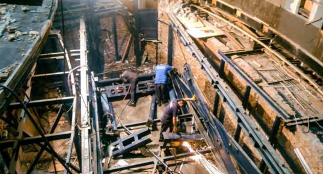
^ Makaslı eski sistem orkestra çukuru demontajı.
