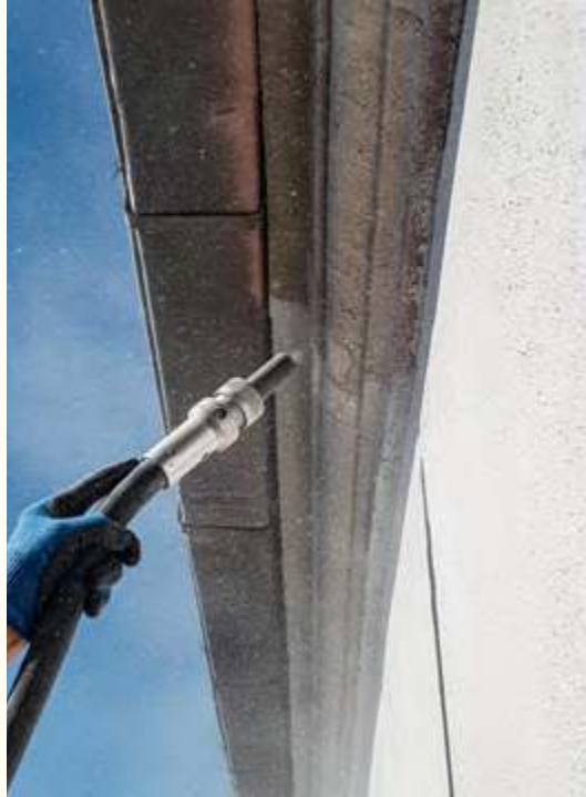
^ Kumlama ile tař ve sve temizliđi.
