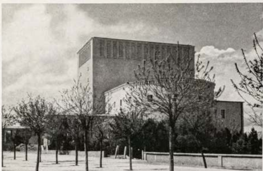
Blick von Nordosten mit dem Bühnenausbau.
