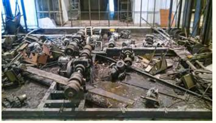
Sahnenin özgün asansör > motor grubu demontajı.
