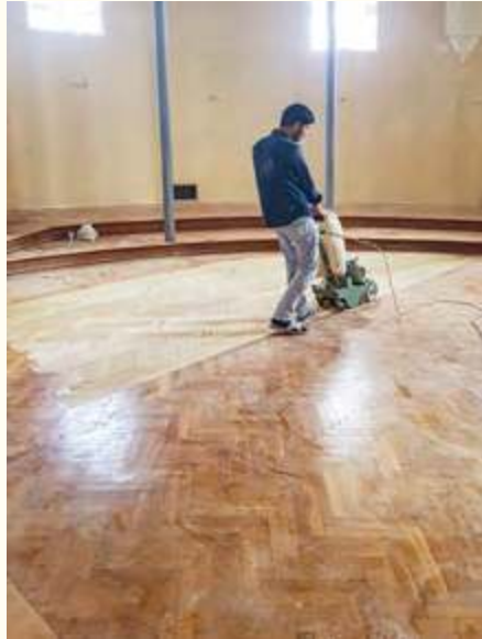
Ahşap kaplama işleri.
